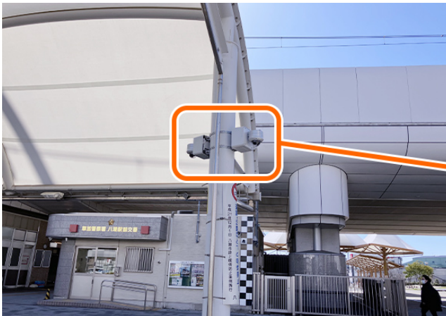
駅前などに設置されているタウンレコーダー。 機器異常発生時は自動メールで通知があるため、現場での定期的なメンテナンスが不要。
