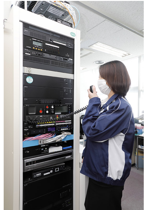
フルマトリクス機能により、案内放送などの業務放送をエリアごとに多元で行うことが可能に。
