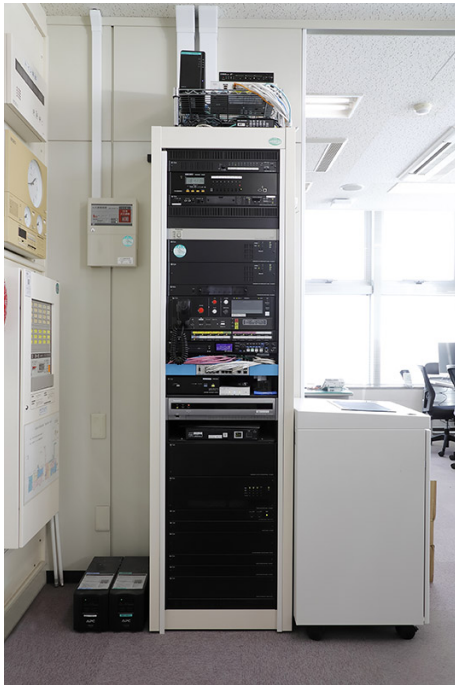
空港ビル内の非常放送、業務放送を行うラック型非常用放送設備 FS-2500シリーズ。
