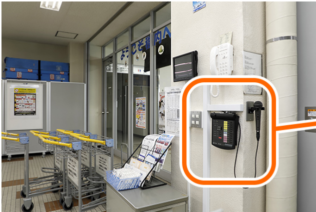
到着口に設置された壁掛け型リモートマイク。
