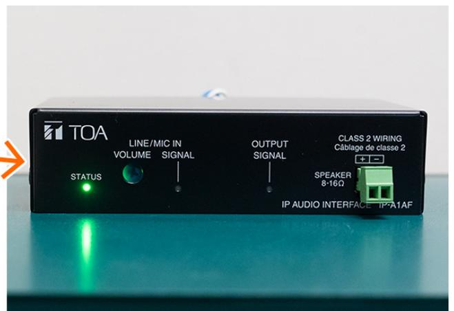
既設設備を活かし放送するために「IPオーディオインターフェース」を設置。IPリモートマイクからのネットワーク音声をアナログ音声に変換し非常用放送設備と連携することで放送を行なっている。
