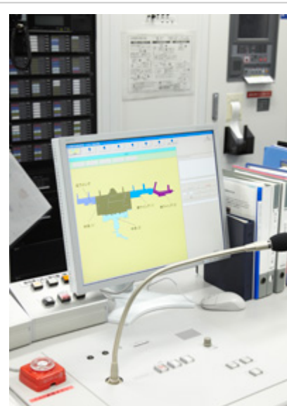
遠隔操作器 コンピューターの画面上に平面図が表示され、直感的に放送エリアを選択できます。
