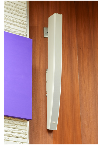
議会場の前面左右に設置されたラインアレイスピーカー。議場内に明瞭な音を届けている。
