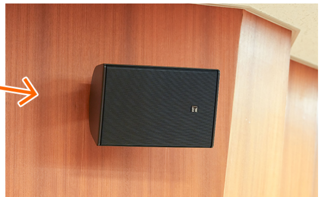
議会場の左右に設置されたコンパクトスピーカー。傍聴席もしっかりとカバーしている。
