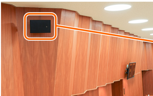
議会場の左右に設置されたコンパクトスピーカー。傍聴席もしっかりとカバーしている。
