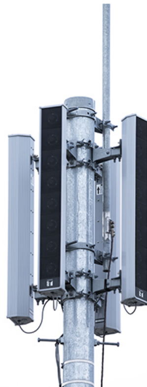
幼稚園敷地内に設置された防災情報伝達システムの屋外子局（防災スリムスピーカー 4 基）。
