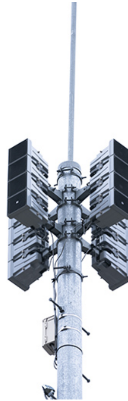
公民館敷地内に設置された防災情報伝達システムの屋外子局（中型ホーンアレイスピーカー 4 連タイプ 4 基）。
