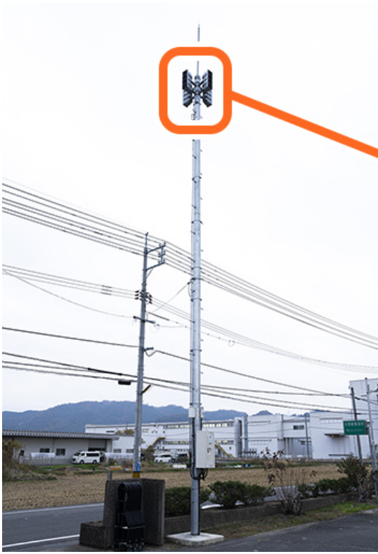
公民館敷地内に設置された防災情報伝達システムの屋外子局（中型ホーンアレイスピーカー 4 連タイプ 4 基）。
