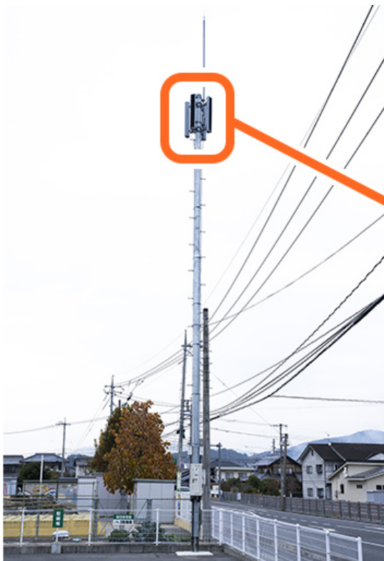
幼稚園敷地内に設置された防災情報伝達システムの屋外子局（防災スリムスピーカー 4 基）。
