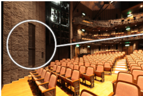
プロセニウムサイドスピーカー。 この中に、SR-C8Sが2台、SR-C8Lが3台、 ウーハーとしてSR-L1Bが2台が入る。
