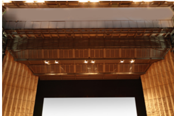
プロセニウムセンタースピーカー。 この中に、SR-C8Sが5台、ウーハーとしてSR-L1Bが2台入る。
