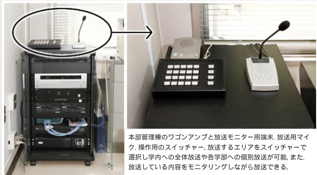
本部管理棟のワゴンアンプと放送モニター用端末、放送用マイク、操作用のスイッチャー。放送するエリアをスイッチャーで選択し学内への全体放送や各学部への個別放送が可能。また、放送している内容をモニタリングしながら放送できる。
