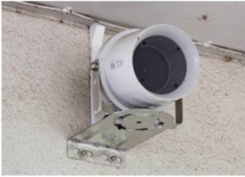
守衛室屋外壁面に設置されているスピーカー。おもに大学構内のバス停でバスを待つ市民にも緊急放送が聞こえるように配慮されている。
