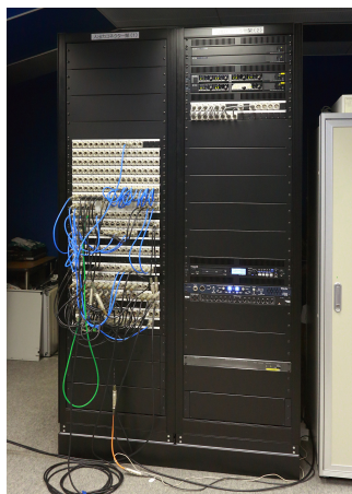
場内放送室にある入出力コネクター架。デジタルワイヤレスチューナーなどが入っている。
