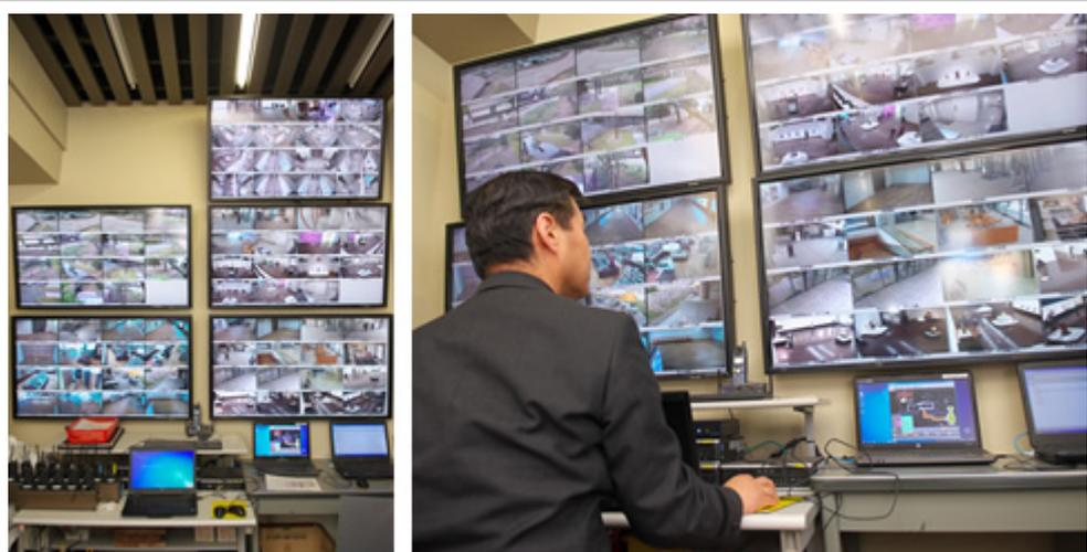
守衛室には5台のモニターが設置され、モニター1台につき16台のカメラ映像を表示。5台のモニターに映っているカメラ映像は、1つのキーボードとマウスで映像の選択、分割表示の変更、コンビネーションカメラの操作や録画映像の確認などが行える。
