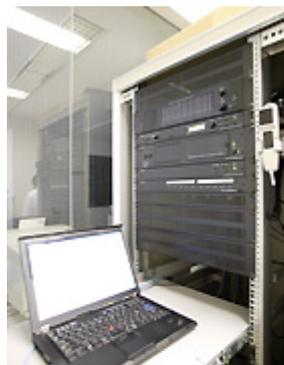
防災センターに設置されているIP告知送信機が組込まれたラック。PCで各端末の死活監視などの操作ができます。
