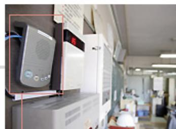
区立小学校の職員室に設置されているIP告知端末（NX-220HU）。既設放送設備に接続されています。
