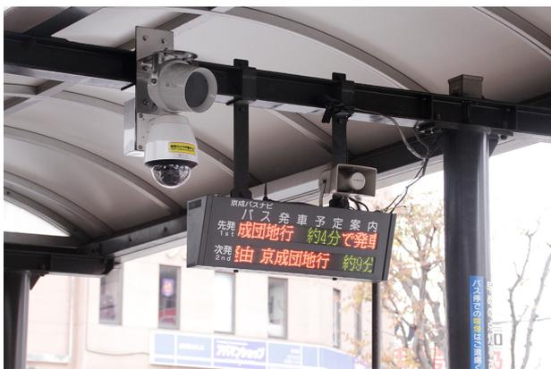
カメラ、レコーダー、デジタルアンプ一体型、LTE通信による省スペース設置で、駅前の道路占用物件の高さ規定もクリア。
