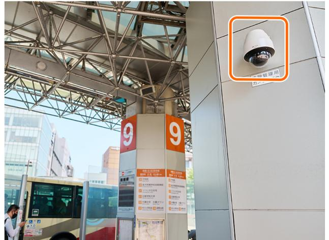
各所に設置された屋外ドーム型AHDカメラ AH-C1810-3（写真左）と、屋外AHDコンビネーションカメラ AH-C1701（写真右）。広大な施設の安心・安全を守るため、警備室で集中管理している。
