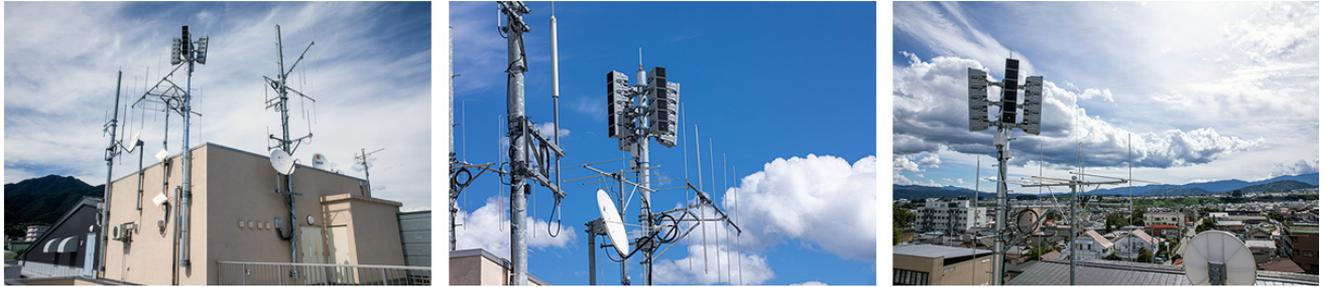
飯田市役所の屋上に設置された防災行政無線システムの中型ホーンアレイスピーカー。360°をカバーし、市街地に向けて放送されている。
