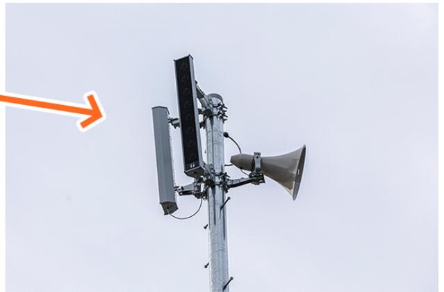
高台の住宅地に設置された防災行政無線子局（防災用スリムスピーカー2基、レフレックスホーンスピーカー）。
