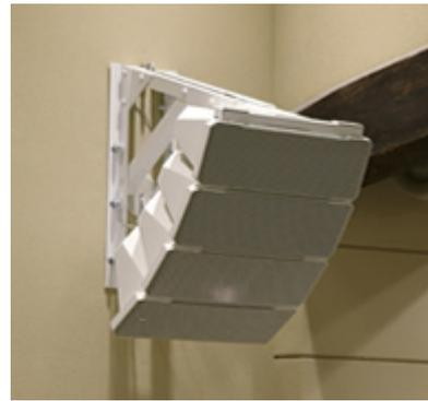
それぞれのバンケットホールの音響設備として設置されているコンパクトアレイスピーカー-HX-7W。その他、デジタルミキサーD-2000シリーズや混信の心配のないデジタルワイヤレスシステムを採用し、祝宴を彩る音環境を構築。
