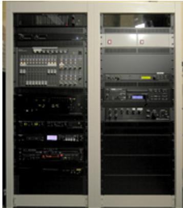
チャペル音響設備の機器収納架。天井の高いチャペルで幻想的な挙式を演出する。デジタルミキサーD-2000シリーズ、デジタルワイヤレスチューナーWT-D1804などを収容。
