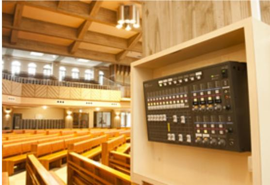
デジタルミキサー専用のラックマウントタイプのリモートコンソールユニット **D-2012C**。大聖堂の音響ラックから離れた場所で、音量調節や事前に調整・保存しておいた各種設定の呼び出し等に使用できる。
