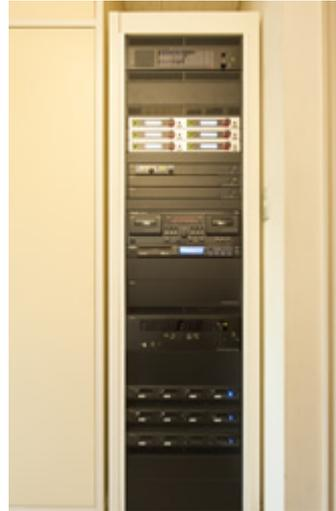
大聖堂の祭壇の後ろにある音響室の音響ラック。デジタルミキサー、デジタルパワーアンプ、ワイヤレスチューナーなどを収納。カトリック福岡司教区における司教座聖堂として全国から利用者が訪れる大聖堂を音響面でサポートしている。
