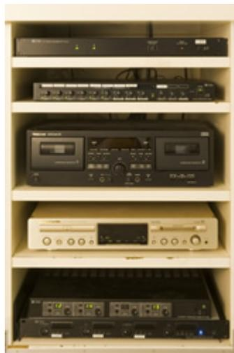
1階の講堂に設置されているラック。中には、デジタルステレオミキサー **M-633D** のほかに、デジタルパワーアンプ **DA-150F**、ダブルカセットデッキを設置。
