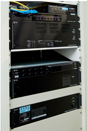
ラック架に収納されている業務放送ラックシステム「VX-3000シリーズ」。アナウンスクリエーターの音源を安比高原スキー場の各コースや施設を細分化して放送することができる。
