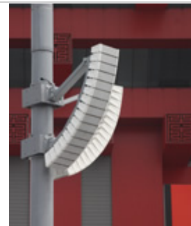
中国館の周囲に設置されている コンパクトアレイスピーカー
