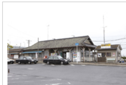
光回線が整備されていない松尾駅周辺。そのため、現場の監視・記録などすべてが屋外で完結できるシステムを構築することが条件となりました
