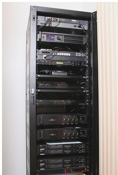
1階エントランスのラック型放送設備。ネットワーク型CM・BGMプレーヤーNA-3000やパワーアンプ等が収められている。
