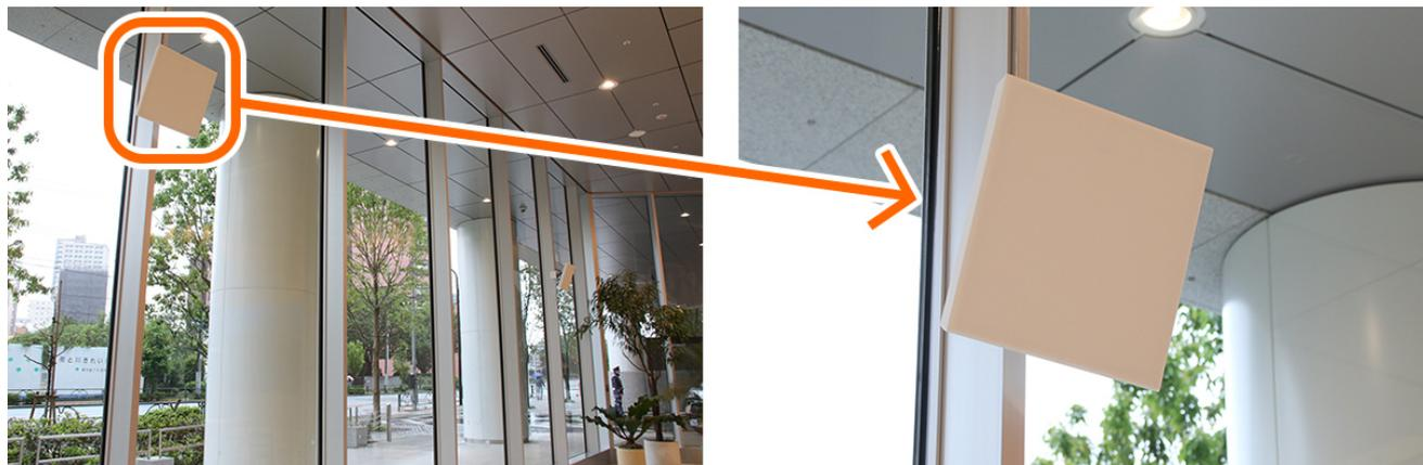
1階エントランスのガラス面に設置したパネルスピーカー。鳥の鳴く音や風の音などが、本当の自然の中で聞いているように感じられるよう設計。また、その場にいる人がさりげなく「ミント畑」が気になるよう、ミント畑に向けて、まるで窓の外から風が流れ込むような音像移動を演出している。
