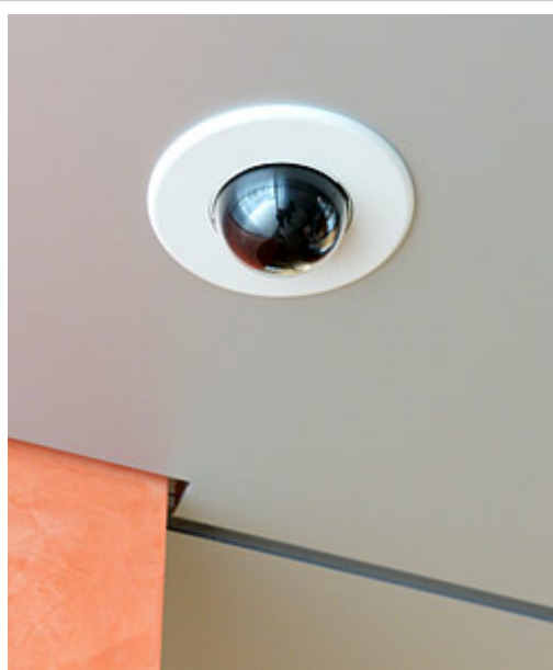
1階駐車場に設置されている屋外HD-SDIカメラH-C1410-3、 出入口をはじめとした各進入ルートに向け、計2台設置されている。
