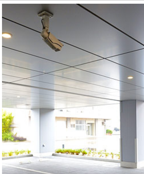
1階駐車場に設置されている屋外HD-SDIカメラH-C1410-3、 出入口をはじめとした各進入ルートに向け、計2台設置されている。
