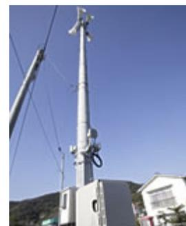
公共施設や市内全域に配置された拡声塔にはIP告知端末が設置されており、ネットワーク経由で伝送されてきた緊急放送を瞬時にスピーカーから拡声します。
