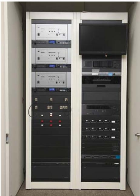
委員会室にある制御機器架。赤外線会議システム TS-800シリーズのセンター装置 3台が設置されている。
