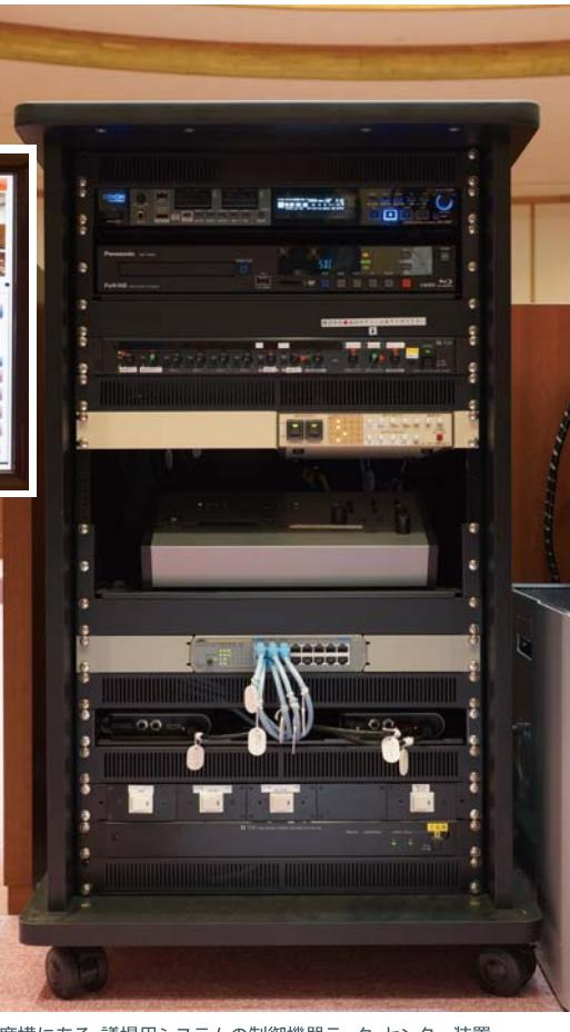
操作席横にある、議場用システムの制御機器ラック。センター装置 TS-910やデジタルミキサーM-633Dなどが収められている。
