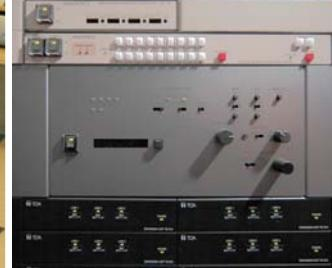
調整室にある議場用システムの機器収納架。有線赤外線統合会議システムのセンター装置 TS-910、デジタルミキサー D-901などが収納されている。
