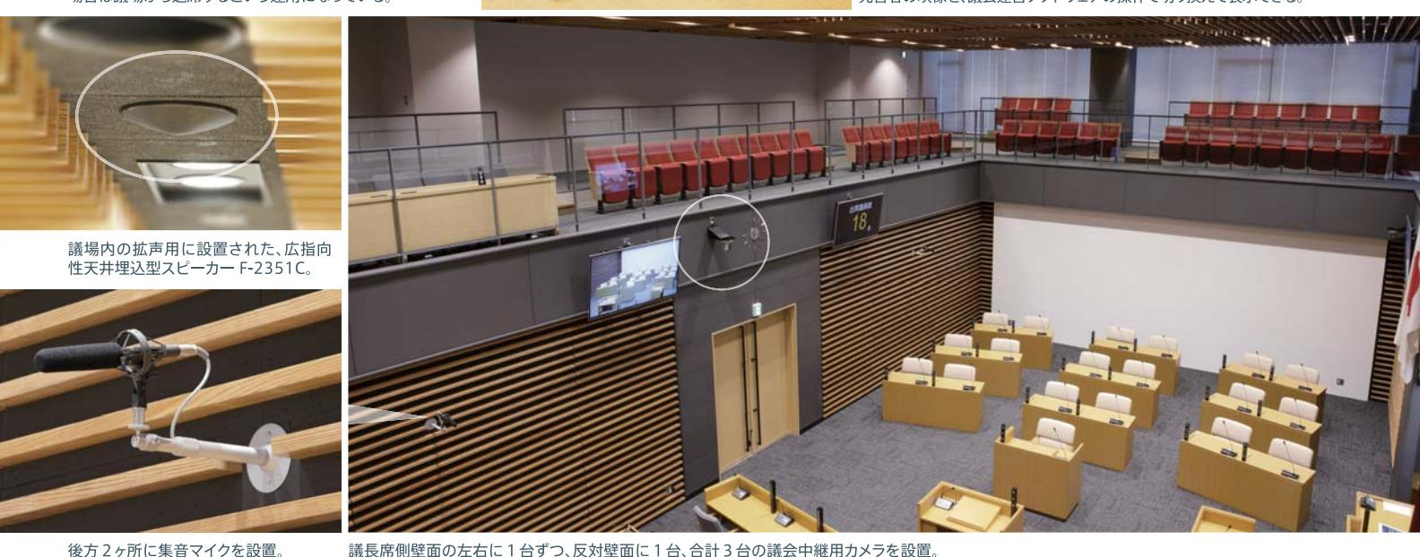
議長席側壁面の左右に 1台ずつ、反対壁面に 1台、合計 3台の議会中継用カメラを設置。
