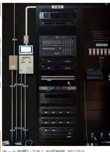
ホール用音響システムの収納架。デジタルミキサー D-2000シリーズ、デジタルワイヤレスチューナー WT-D1804、デジタルパワーアンプ DA-550Fなどを収納。
