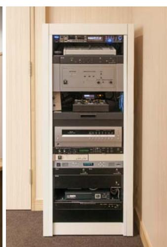
操作席横にある、議場用システムの制御機器ラック。センター装置 TS-800やデジタルプロセッサー DP-M3などを収納。
