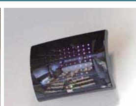
難聴者補助システムとして、傍聴席に設置された赤外線ラジエーター。
