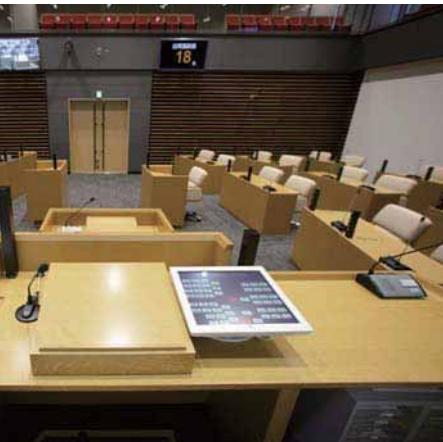
議長席にはグースネック型コンデンサーマイク EM-800が設置されている。右にある液晶モニターで出席状況や発言状況、採決結果などが確認できる。
