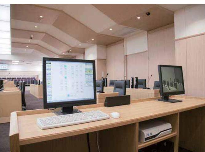
赤外線会議システムの操作ソフトウェアQ-TS-900SWMで、マイクユニットの操作やモニターへの表示などの制御を行っている。庁舎内へ配信される映像はモニターで確認できる。
