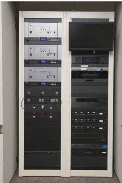
委員会室にある制御機器架。赤外線会議システム TS-800シリーズのセンター装置 3台が設置されている。
