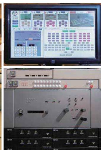
調整室にある議場用システムの機器収納架。有線赤外線統合会議システムのセンター装置 TS-910、デジタルミキサー D-901などが収納されている。
