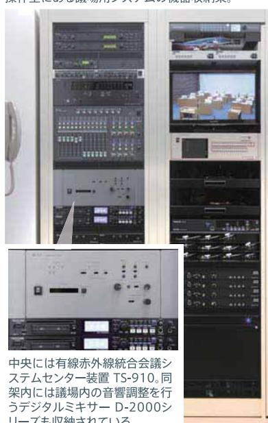
中央には有線赤外線統合会議システムセンター装置 TS-910。同架内には議場内の音響調整を行うデジタルミキサー D-2000シリーズも収納されている。
