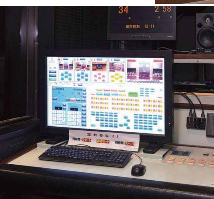
モニター室の調整卓。マウス操作により、会議システム、カメラシステム、発言残時間システム、テロップ、電子採決システムの制御を主にこちらで行っている。
